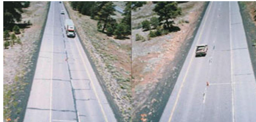
Normál bitumennel épített út
