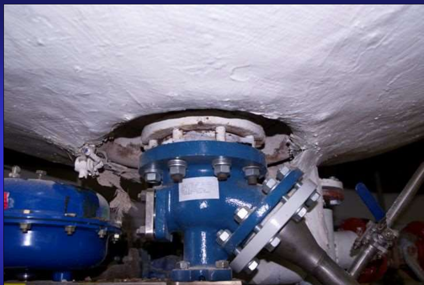
A készülék csavarjai láthatóan megnyúltak.
